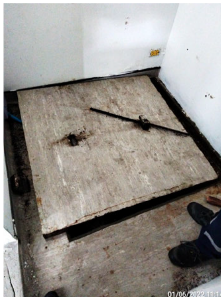
ภาพที่ 2-18 ฝาบ่อเก็บน้ำใต้ดินปิดมิดชิด
