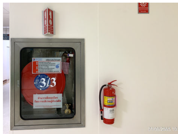
ถังดับเพลิง และตู้เก็บสายฉีดน้ำดับเพลิง
