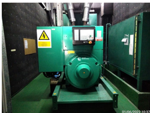
ภาพที่ 2-14 เครื่องกำเนิดไฟฟ้าสำรอง
